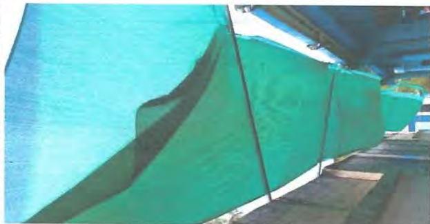
Foto1: Se instalara entechado en el area de recreacion debido a que no se cuenta con sombra.
